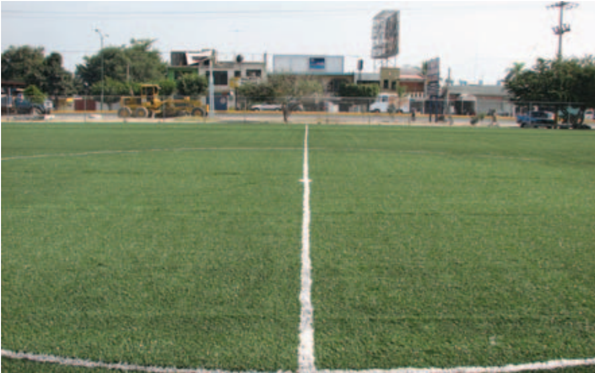
Rehabilitación y mejoramiento de cancha de fútbol en la unidad deportiva Galeana 1ª etapa.
