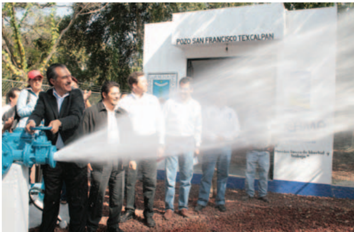
Sistema San Francisco Texcalpan del Municipio de Jiutepec, donde se invirtieron 9 millones 770 mil 928 pesos.
