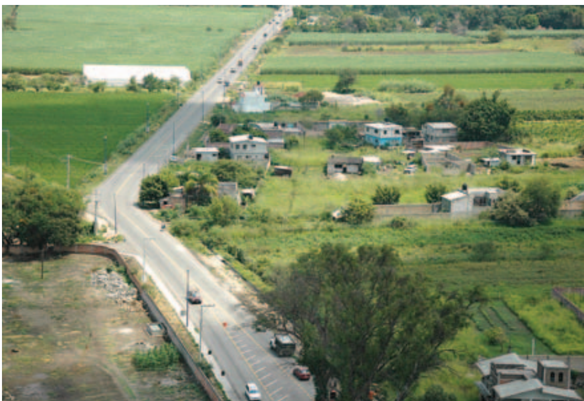
Distribuidor vial Oaxtepec - Cocoyoc.
