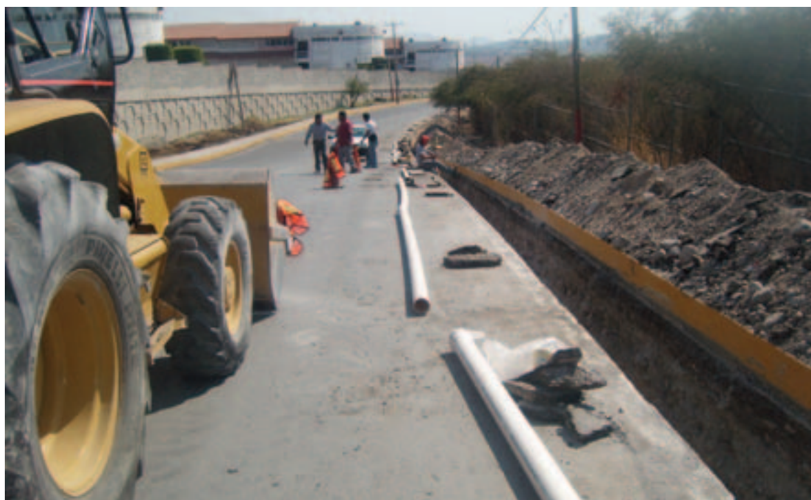
Rehabilitación de red de distribución de agua potable en el Municipio de Emiliano Zapata, con una inversión de 2 millones 58 mil 657 pesos.
