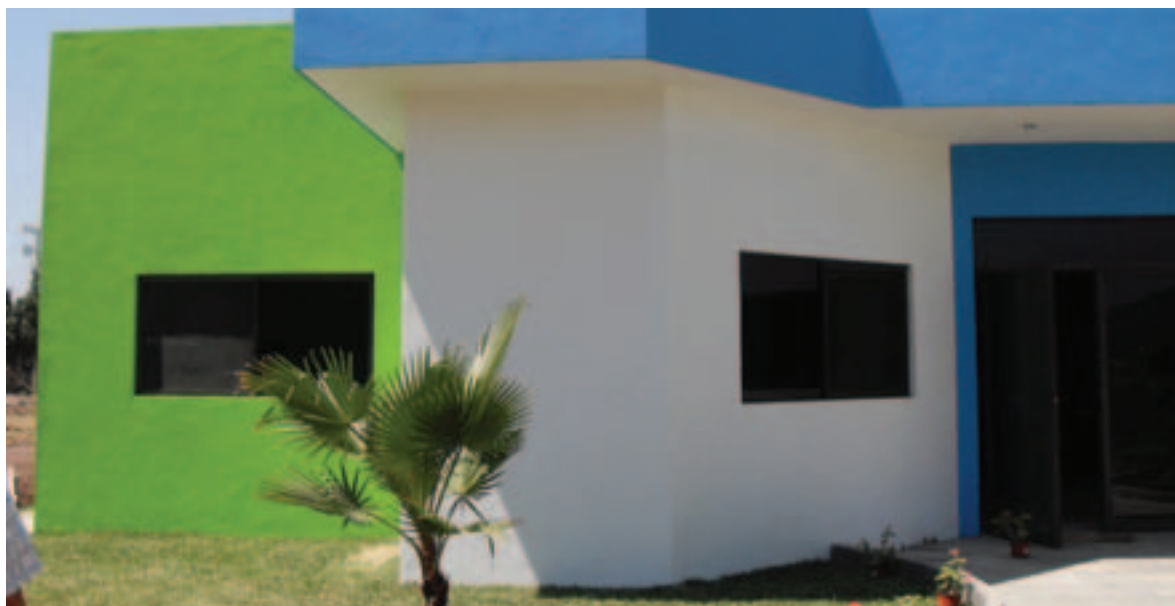
Construcción de Unidad Básica de Rehabilitación (UBR) para el sector salud en Emiliano Zapata.
