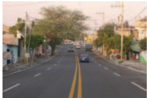
Modernización del tramo carretero Tlaquiltenango-Tlaltizapán.
