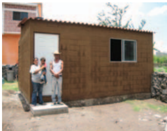
Construcción de unidad básica de vivienda (después).
