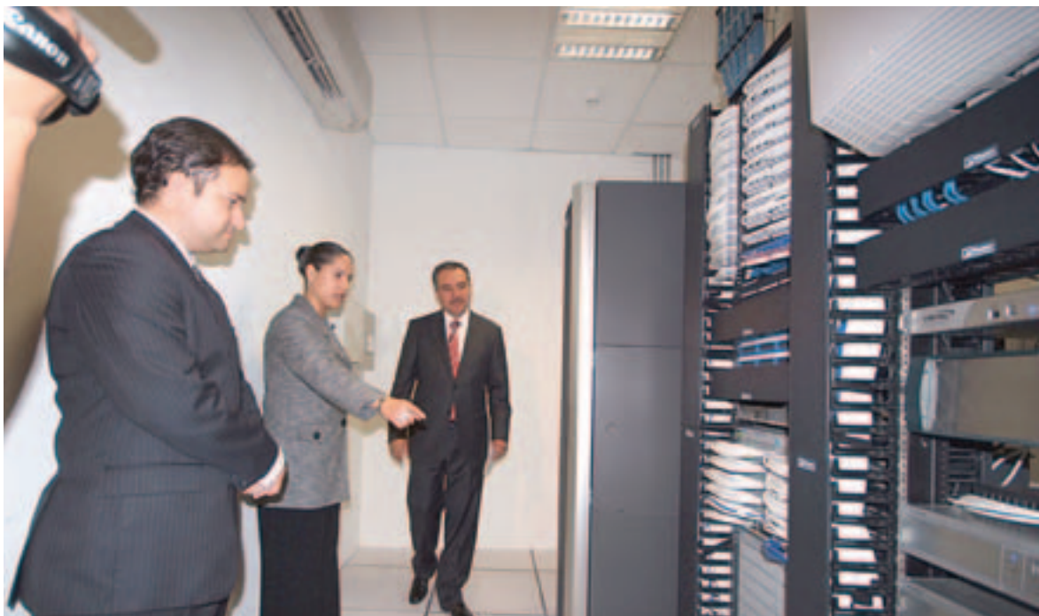
Cuarto de telecomunicaciones de la Junta Local de Conciliación y Arbitraje.
