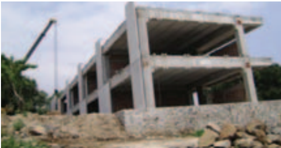
Construcción del Edificio "C" aulas número 2 de la Facultad de Psicología, en la Universidad Autónoma del Estado, Chamilpa-Cuernavaca. El Edificio consta de ocho aulas, dos módulos de sanitarios, dos bodegas, escaleras y obra exterior: cisterna con capacidad de 30 m 3 , tanque elevado con capacidad de 20 m 3 , subestación eléctrica tipo pedestal 500 kva, plazas y andadores residuales y equipamiento en el CONALEP s/n colonia Azteca del Municipio de Temixco.
