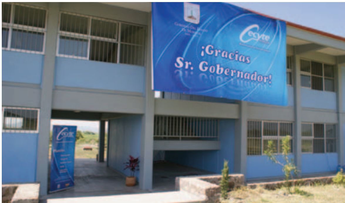
Construcción de la primera etapa del plantel 04 del Colegio de Estudios Científicos y Tecnológicos del Estado de Morelos, ubicado en la localidad de Tlayecac, Municipio de Ayala.
