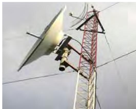
*Instalación típica de antena Canopy.*
